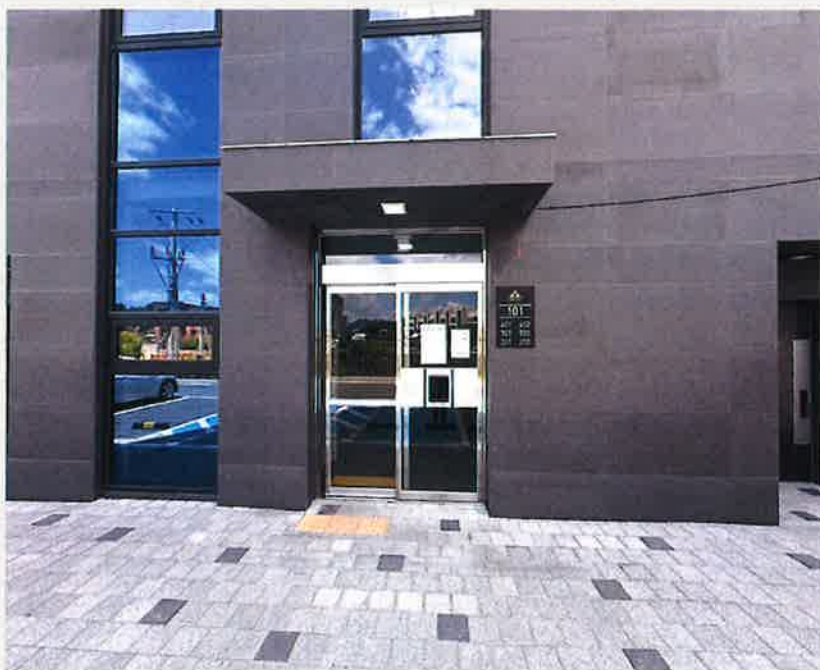
【 일련번호(나) 제101동 1-2라인 1층 공동출입구 】
