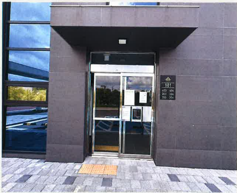
【 일련번호(가) 제101동 3-4라인 1층 공동출입구 】
