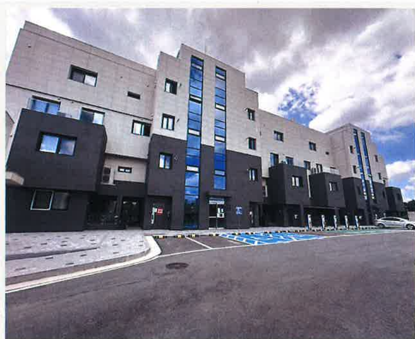
【 대상물건 제101동 전경 】
