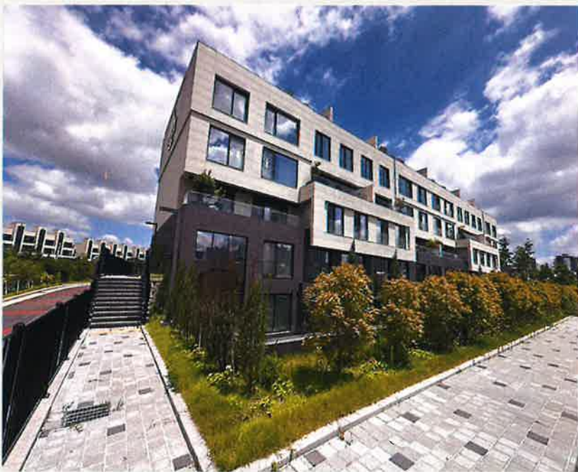
【 대상물건 제101동 전경 】
