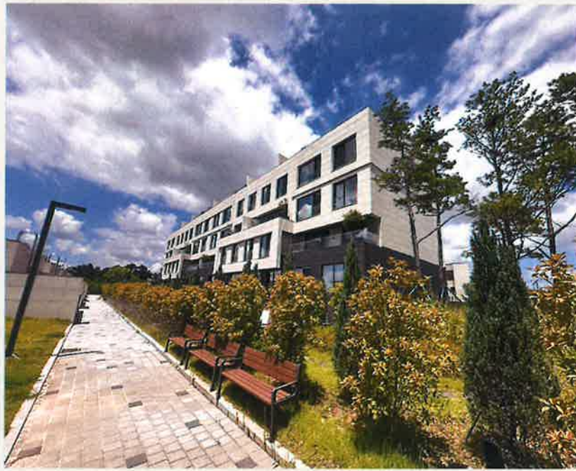
【 대상물건 제101동 전경 】
