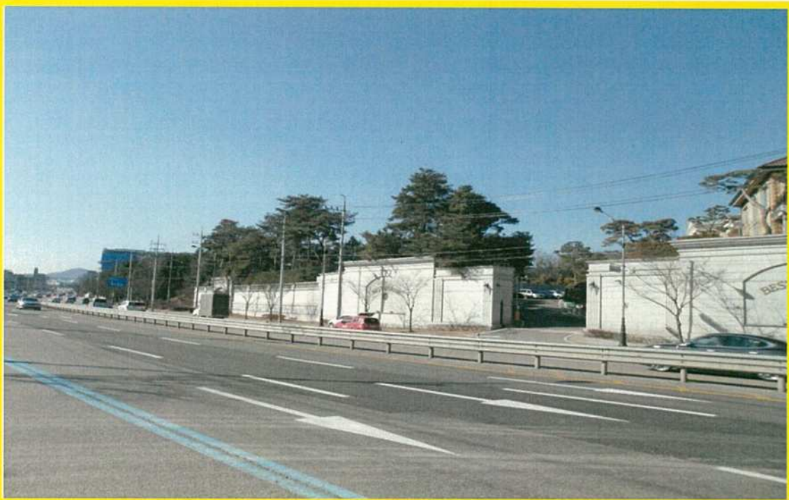
[ 대상물건 전경 - 북동측에서 촬영 ]
