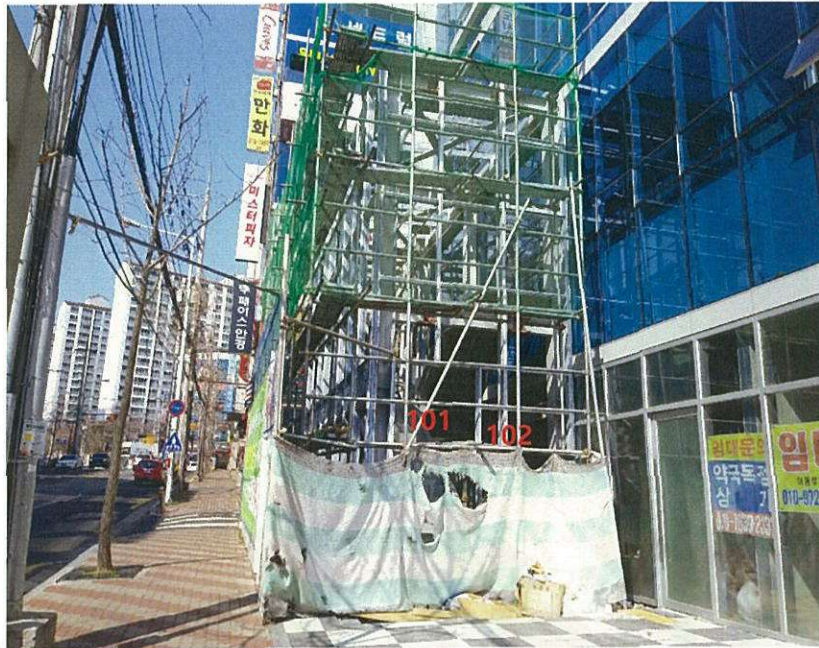
(1) 제1층 제101호, (2) 제1층 제102호 외부 및 전면 설치중인 철골조 계단
