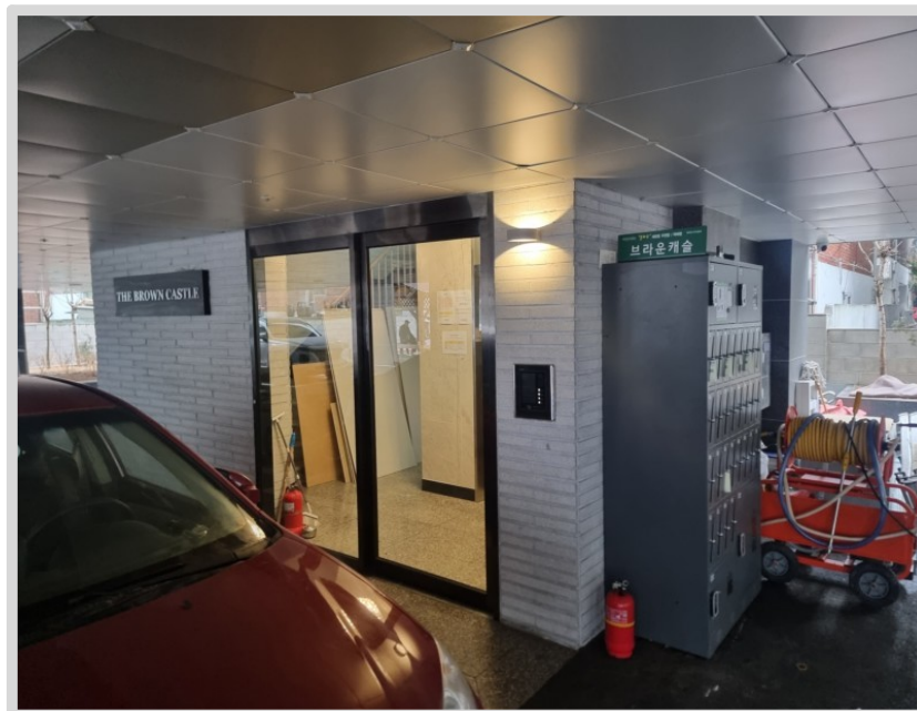
【본건 출입구 전경】
