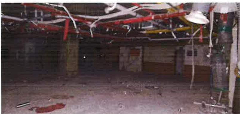
【 지하 2층 1호 전경 】
