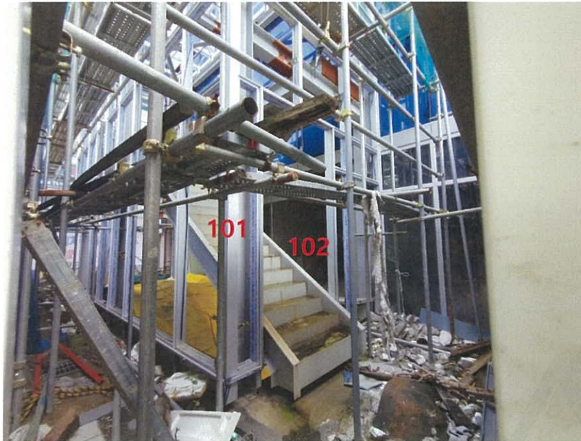
(1) 제1층 제101호, (2) 제1층 제102호 외부 및 전면 설치중인 철골조 계단 - 남서측 촬영
