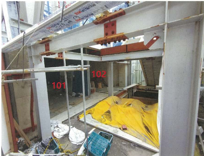
(1) 제1층 제101호, (2) 제1층 제102호 외부 및 전면 설치중인 철골조 계단 - 북서측 촬영
