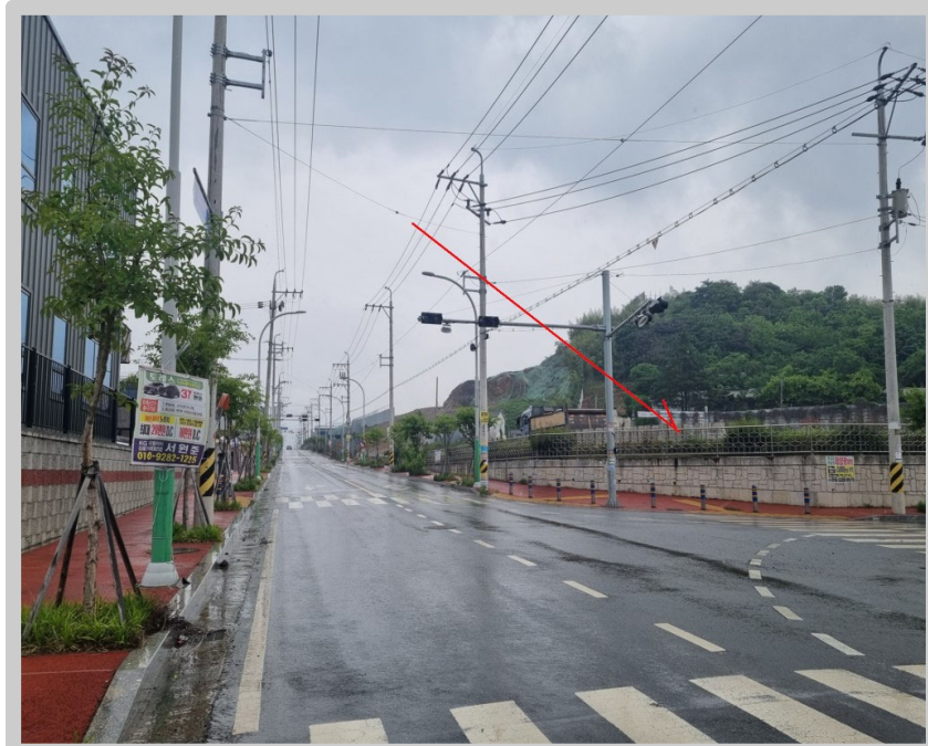
【 일련번호 4. 1227 주차장 주변전경 】
