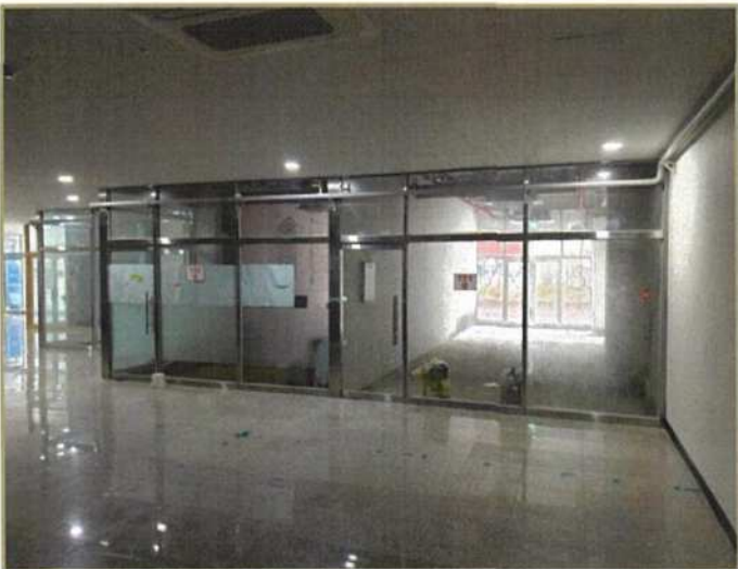
본건 1층 내부(101호 주변)
