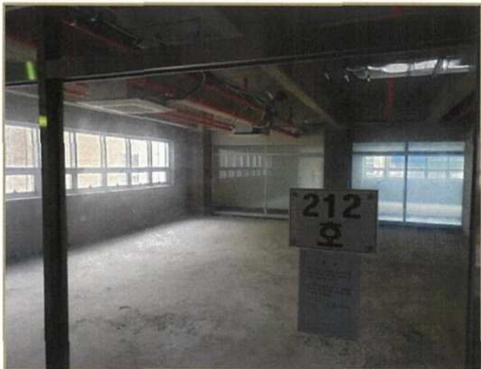
본건 2층 내부(212호 주변)
