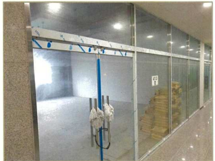
본건 4층 내부(413호 주변)
